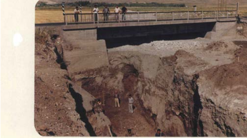
Şekil 15.- Telçeker yakınında Devlet Karayolu köprüsü.
